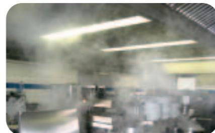
Der Wirkungsgrad von Hauben und Decken mit SysGREEN-Funktion liegt deutlich über dem von herkömmlichen Zu-/Abluftsystemen. Etwa 50 % des abgesaugten Luftstroms werden durch die intern eingeblasene, unerwärmte Zuluft ersetzt, lediglich die Hälfte der Frischluft muss erwärmt werden.
